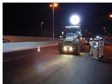
写真-3 本線上の試験施工状況
