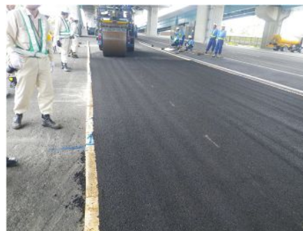
写真-2 路下確認試験施工状況
