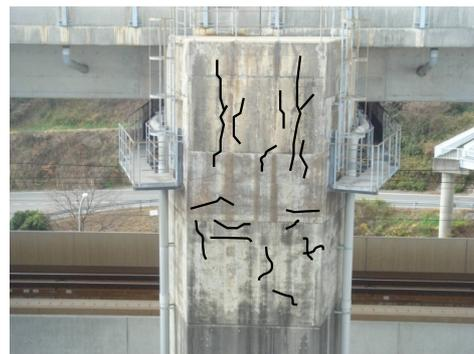
写真-2 ASRによるひび割れの状況
