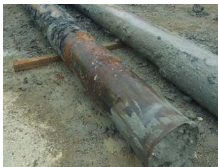
写真1 引抜杭の状況
