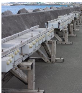
写真-1 暴露状況
