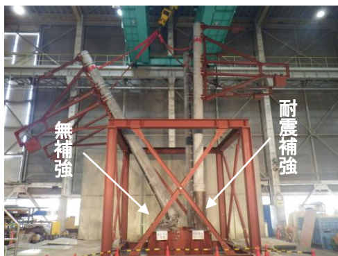
写真-3 振動台試験後 (全景)
