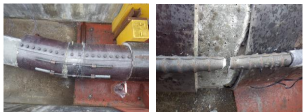
写真-1 曲げ試験後
