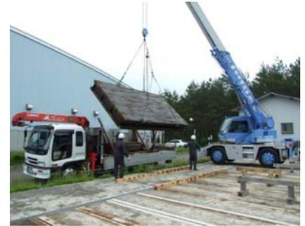
写真6 橋本体の積み込み
