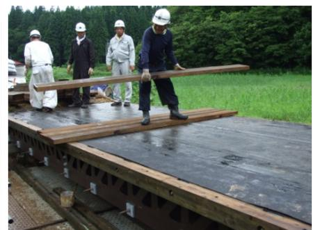
写真9 防水シートと床板の敷設
