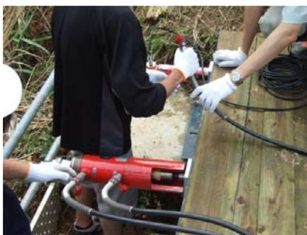
写真8 PC鋼棒の緊張
