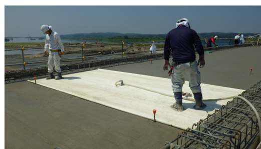
写真-1 真空脱水工法
