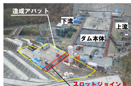
図-8 施工状況写真
