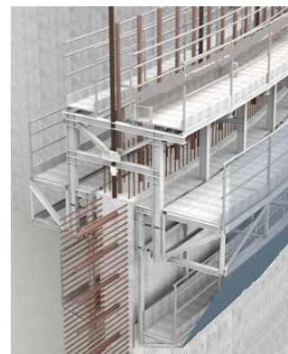
図-2 スリップフォーム工法のイメージ
