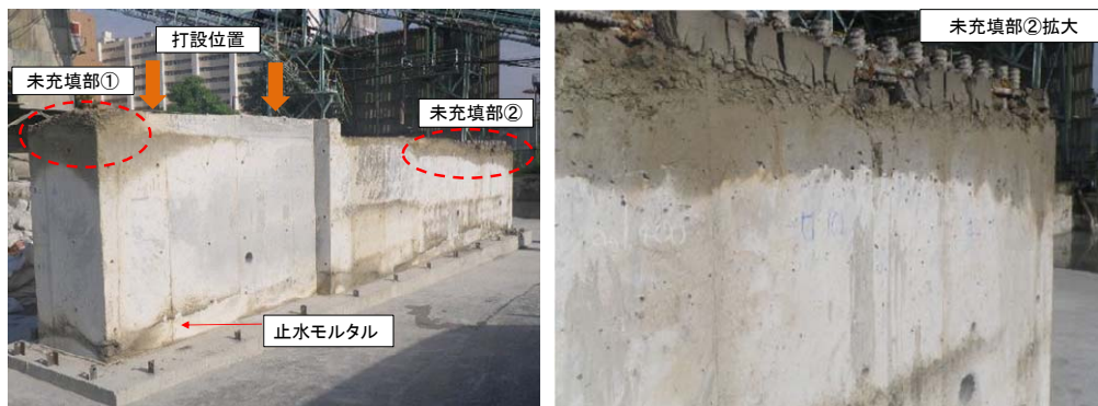
写真-1 コンクリートの充填状況
