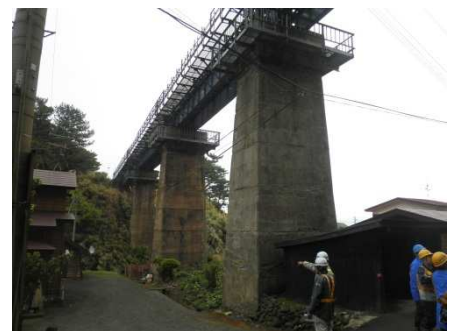
写真-1 橋梁全景
