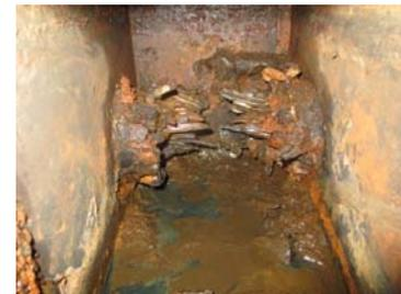
図-5 PC 鋼より線腐食破断の状況
