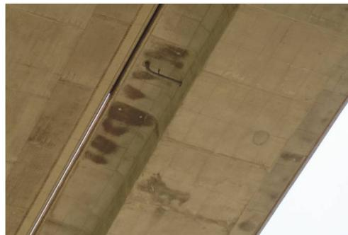
図-1 床版下面に発生した水シミ
