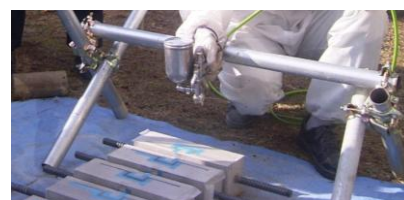
図-3 スプレーガンによる吹付け塗布状況
