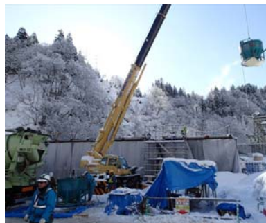
写真-2 打込み状況（実施工）
