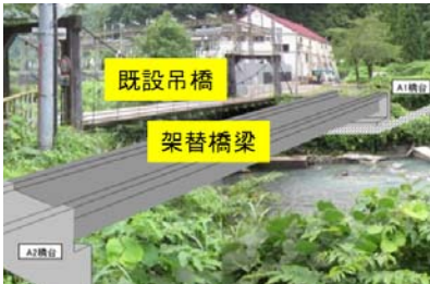
写真-1 架設地点状況
