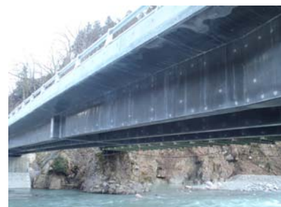
写真-3 仕上がり状況
