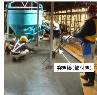
写真-2 打込み状況（実施工）
