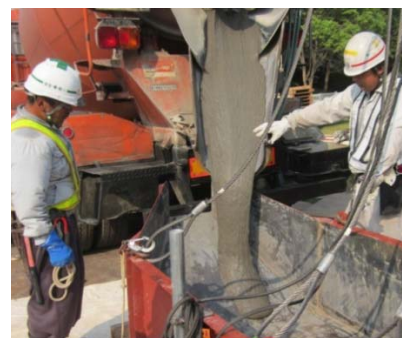
写真-1 荷卸し状況
