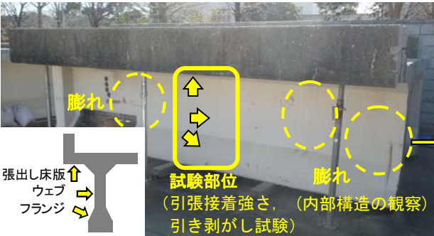
a) 海側の桁中央部から切出した試験体
