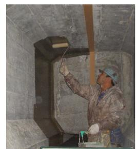
写真-1 部材への塗布状況
