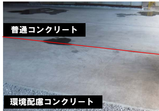
写真 1 環境配慮コンクリートの様子(材齢 42 日)
