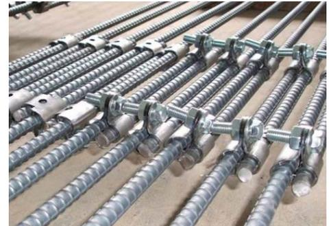
写真 1 締付金具を用いた鉄筋継手
