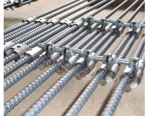
写真 1 締付金具を用いた鉄筋継手
