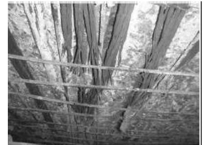
写真-4 PC 鋼線破断事例<sup>4).5)</sup>
