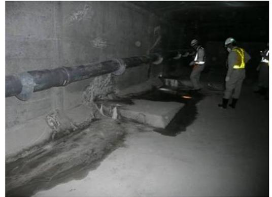
写真-1 PC箱桁橋内部の漏水
