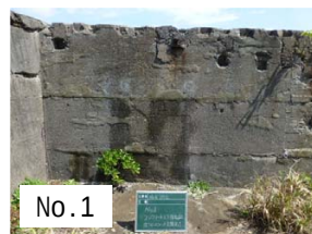
No.1 南東側護岸 昭和 6 年拡張
