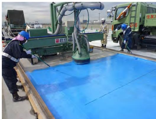
写真-1 接着剤塗布ユニット(集塵機構付き)
