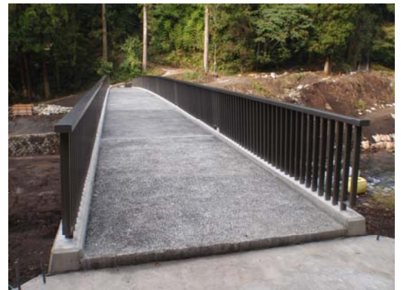
写真-4 地場材を用いた洗い出し舗装
