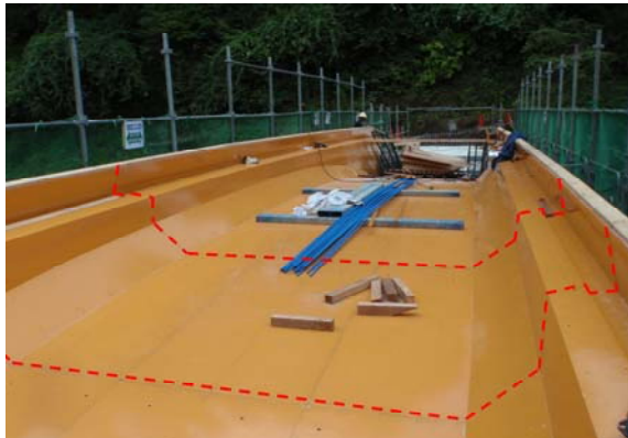
写真-2 型枠設置状況 (破線は合わせ目地)
