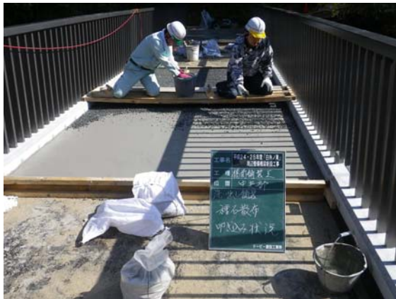
写真-3 種石散布・叩き込み状況
