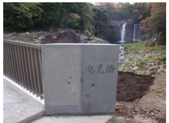
写真-5 大沢石を用いた親柱
