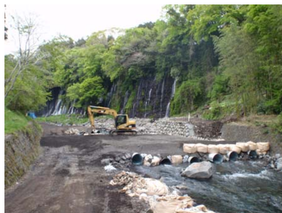
写真-1 瀬替え施工状況
