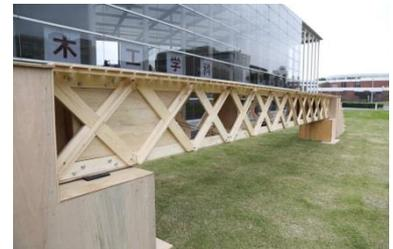
写真-4 せん断補強パネル
