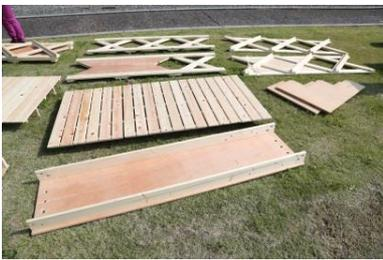
写真-2 1 ユニットの部材を板状に分解したもの
