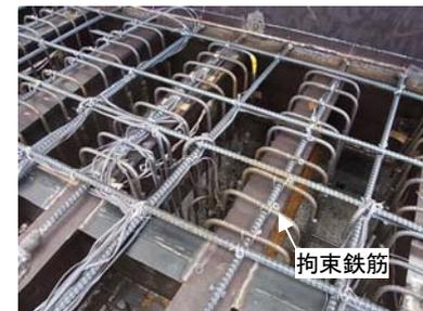
写真-2 拘束鉄筋の配置状況
