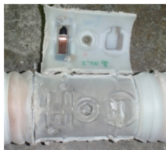
写真-2 グラウト充填状況
