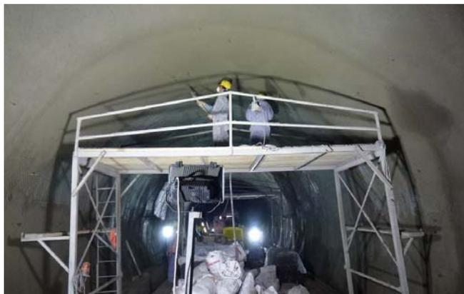
写真1 耐火材吹付け状況
