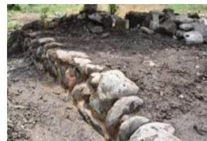
図-9 修復が完了した空石積み
