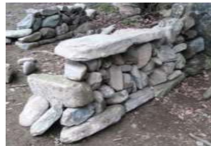
図-8 仮組した空石積み
