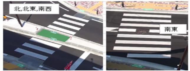
図1 路面標示シート設置の様子
