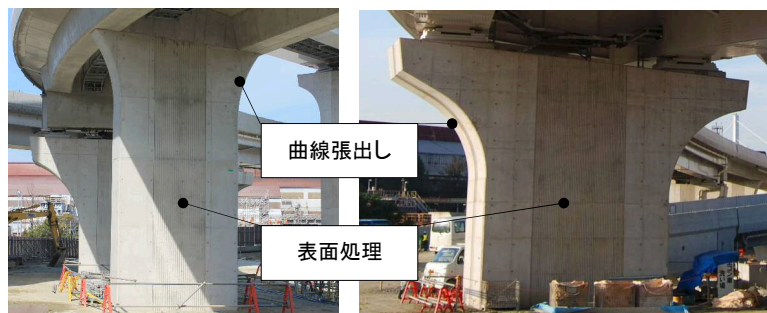
写真-1 ラーメン橋脚(左)と支承を有する橋脚(右)の意匠
