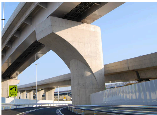
写真-2 完成した PA8
