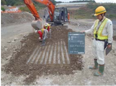
写真—1 損傷確認試験状況
