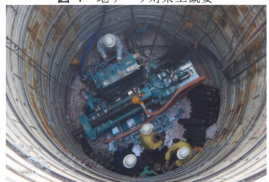
写真-3 集水井内ボーリング施工状況
