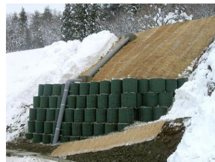
写真1 円筒金網工法の外観
