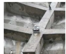
図-3 荷重計の設置状況
