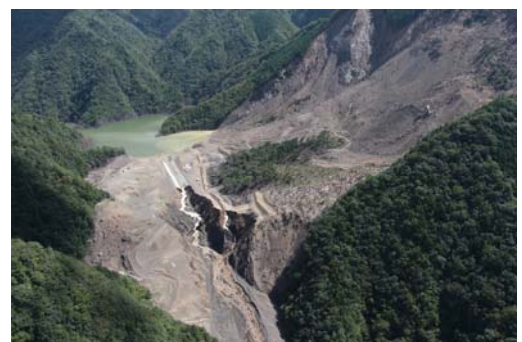
写真－3 仮排水路流失後の状況
