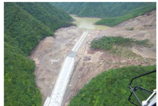
写真－2 仮排水路完成後の状況
