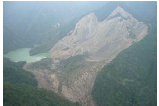
写真－1 栗平地区天然ダム
