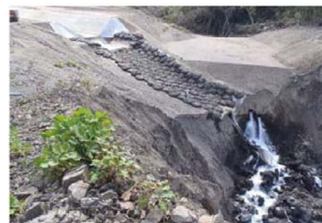
写真-5 暗渠管からの排水状況
