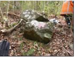
写真-4 調査困難(箇所10)
