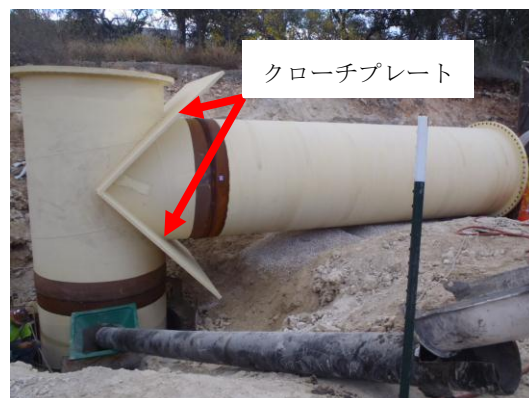
写真—1 クローチプレート (例)
