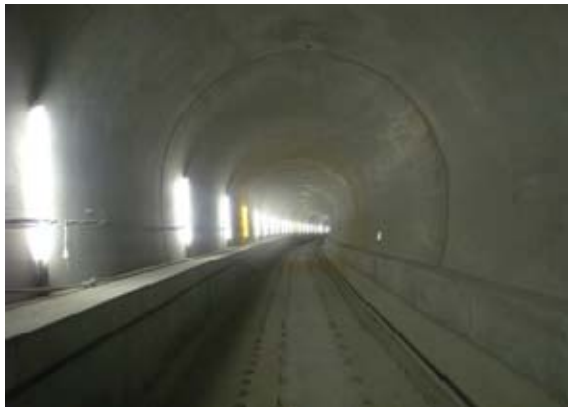
図-4 脱型後の覆工面
