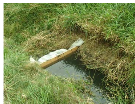
写真-1 滞水状況 (20m 地点の堰)
