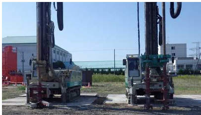
写真-1 スマートコラム工法
