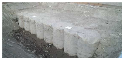
写真-2 改良体の掘り出し状況
