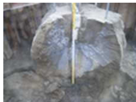
図-4 割裂面状況
