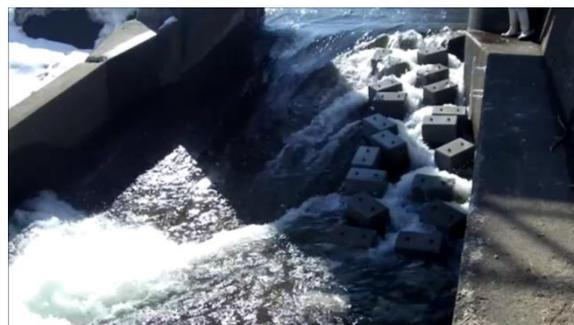
写真2 土砂吐き上にブロックが設置された場合の流況
