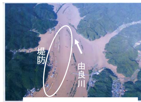
写真 1 浸水状況と堤防
