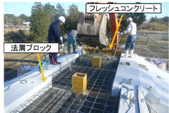
図-9 新形式モデルにおける天端コンクリートの打設状況
