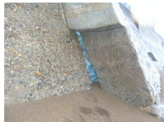
図-6. 護岸壁損傷箇所
