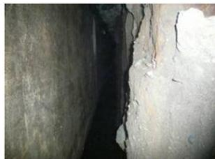
図-3. 陥没穴奥空洞
