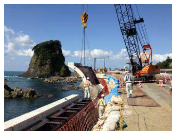
写真 3 現地施工状況
