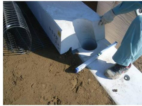
写真-2 ブロックの連結孔
